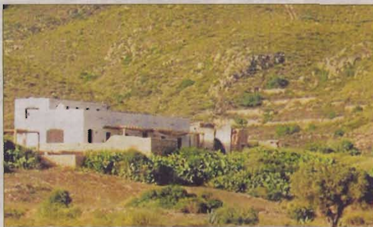
■ El cortijo ecológico La Tenada ha sido rehabilitado de manera sostenible.
